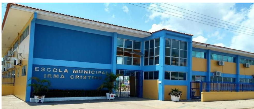
Foto 06: Escola Municipal Irmã Cristinne, Endereço: Rua João Pessoa Lopes N: 3990 Bairro: Itaúna II
