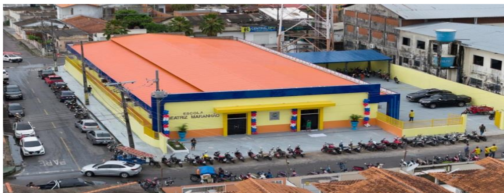
Foto 03: Escola Municipal Beatriz Maranhão, localizada na Rua Pedro Ferreira Gonçalves Nº1886 Bairro Centro
