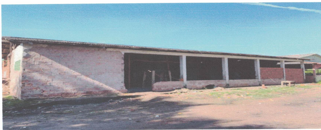
VISTA FRONTAL DA OBRA
