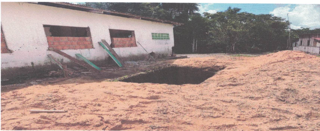
ESCAVAÇÃO DA FOSSA E SUMIDOURO
