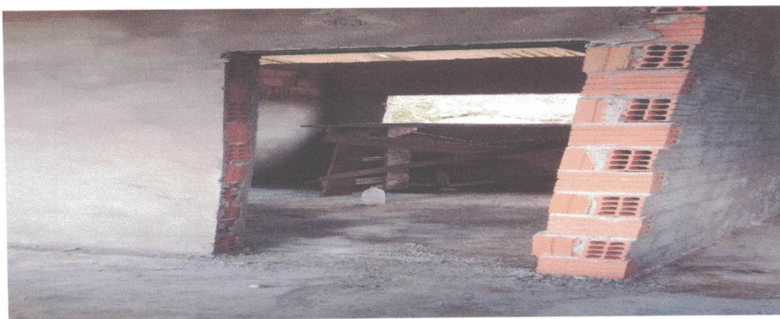
SERVIÇOS DE ALVENARIA
