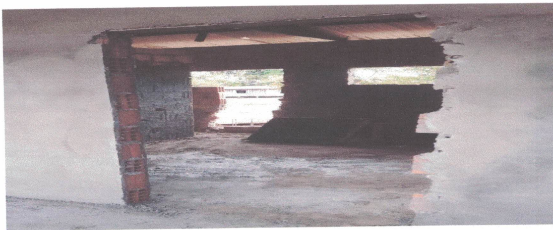
SERVIÇOS DE CHAPISCO E REBOCO
