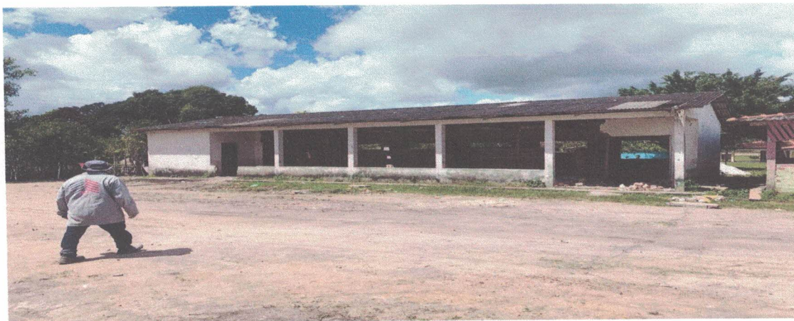
VISTA FRONTAL DA OBRA
