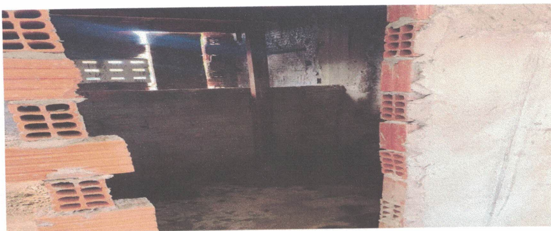
SERVIÇOS DE ALVENARIA
