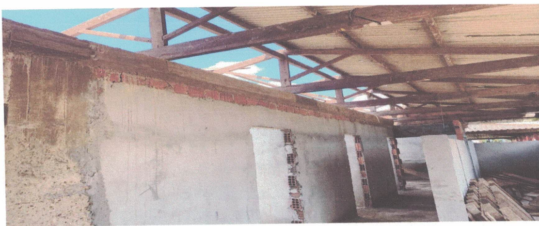
COBERTURA PARCIALMENTE RETIRADA PARA CONCRETAGEM DA LAJE
