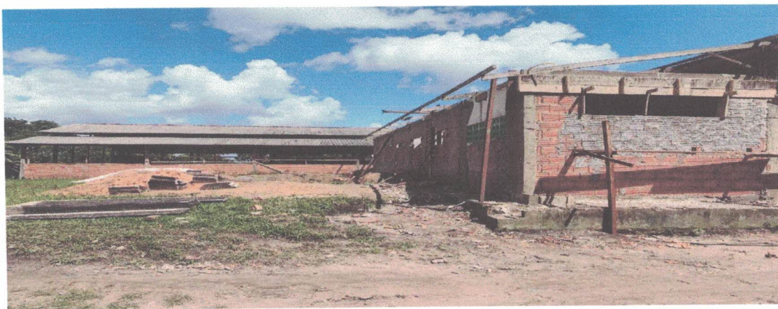
COBERTURA PARCIALMENTE RETIRADA PARA CONCRETAGEM DA LAJE
