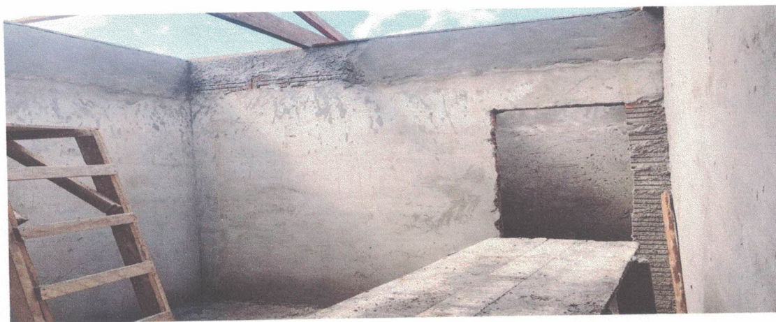
SERVIÇOS DE CHAPISCO E REBOCO
