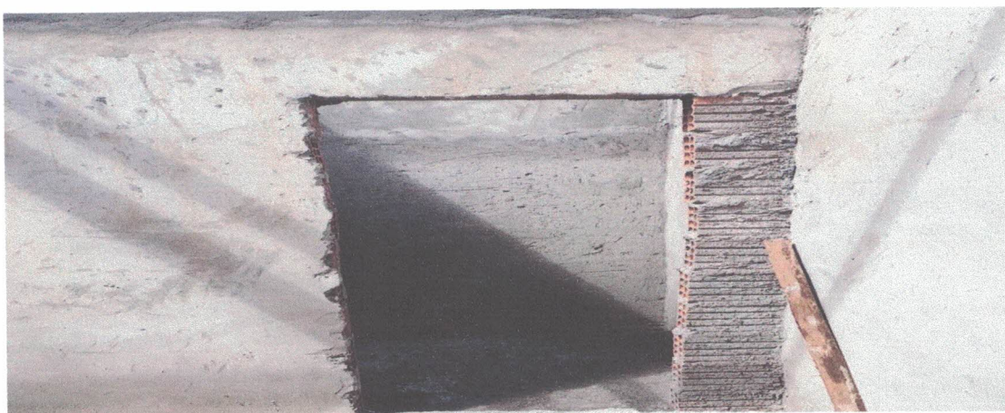
SERVIÇOS DE CHAPISCO
