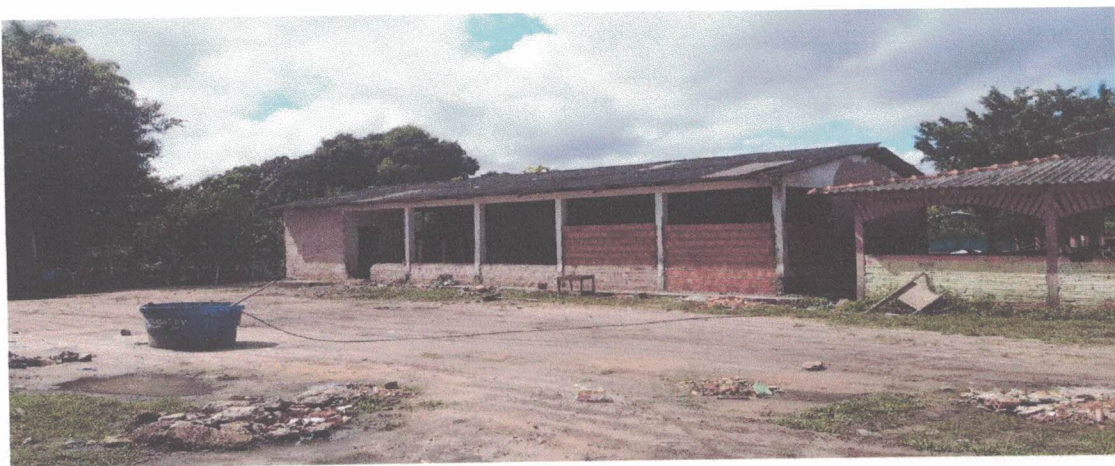
VISTA FRONTAL DA OBRA
