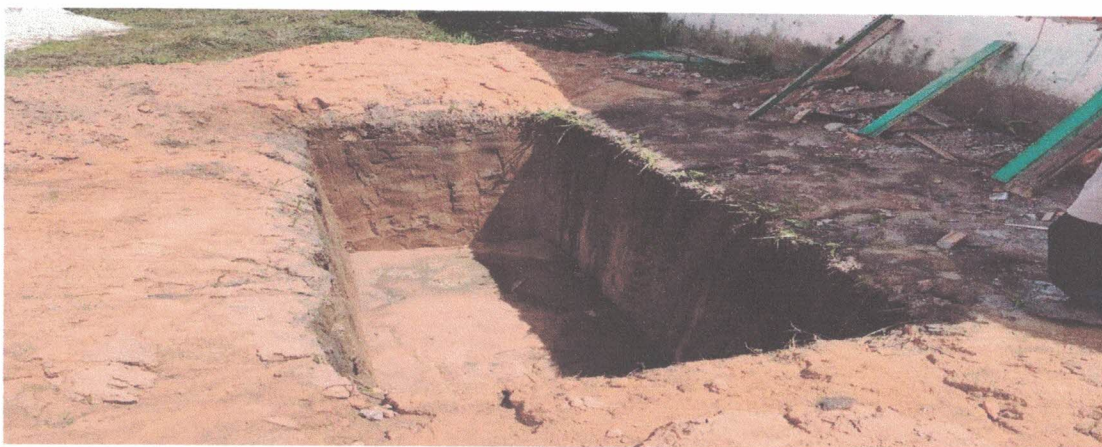
ESCAVAÇÃO DA FOSSA E SUMIDOURO
