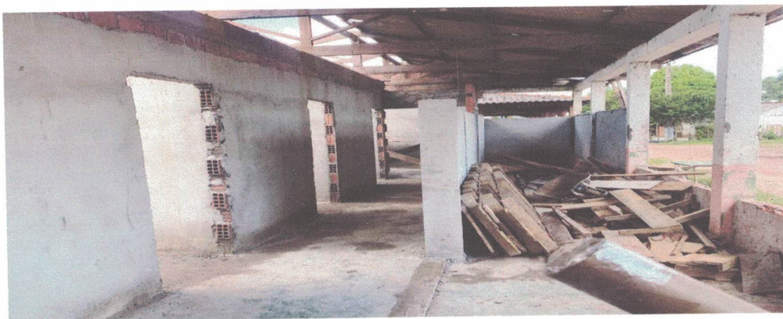
SERVIÇOS DE CHAPISCO E REBOCO
