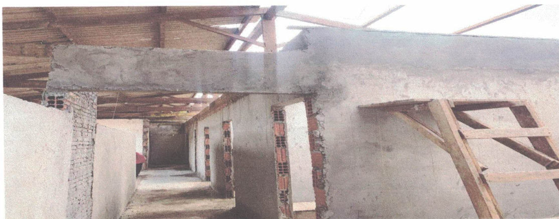
COBERTURA PARCIALMENTE RETIRADA PARA CONCRETAGEM DA LAJE
