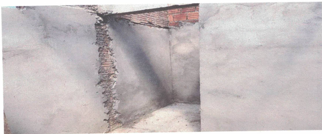
SERVIÇOS DE CHAPISCO E REBOCO
