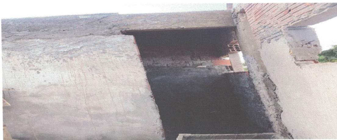
SERVIÇOS DE CHAPISCO E REBOCO
