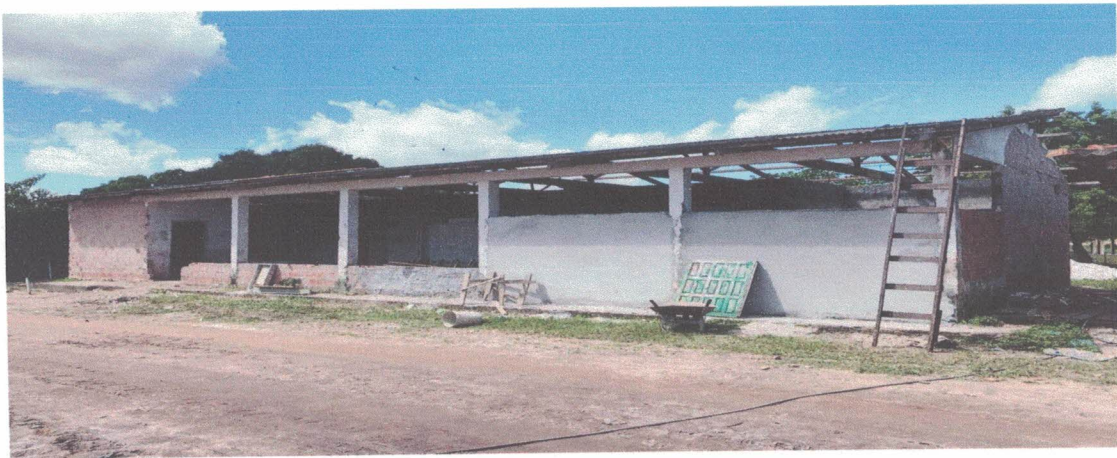
VISTA FRONTAL DA OBRA
