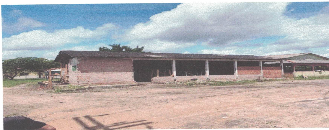
VISTA FRONTAL DA OBRA
