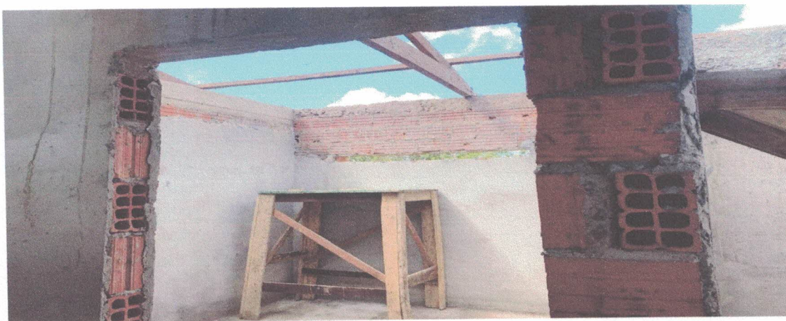
SERVIÇOS DE CHAPISCO E REBOCO
