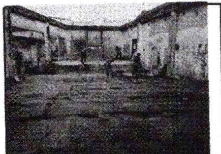
Limpeza e Demolições
