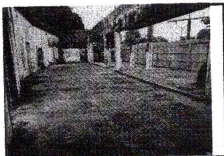
Limpeza e Demolições
