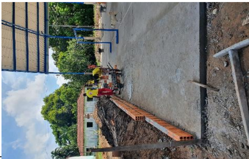
ATERRO E EXECUÇÃO DA ALVENARIA DO PALCO
