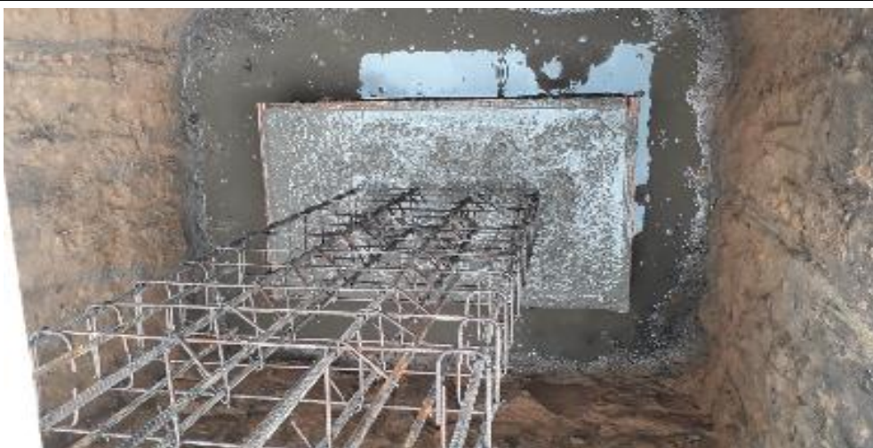
CONCRETAGEM DE BLOCO DE FUNDAÇÃO
