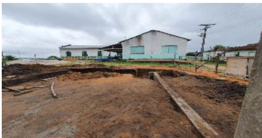
VIGA BALDRAME CONCRETADA
