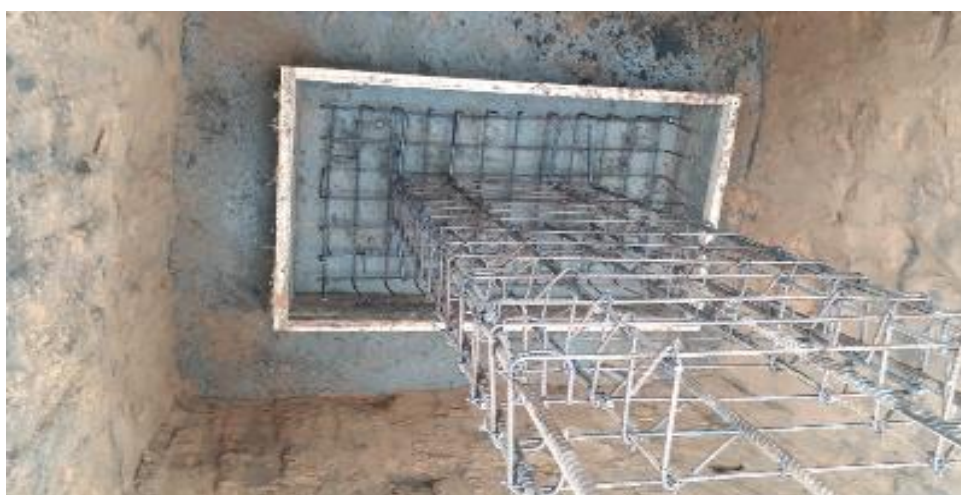
FORMA, FERRAGEM E CONCRETO MAGRO AO FUNDO DE UM BLOCO DE FUNDAÇÃO
