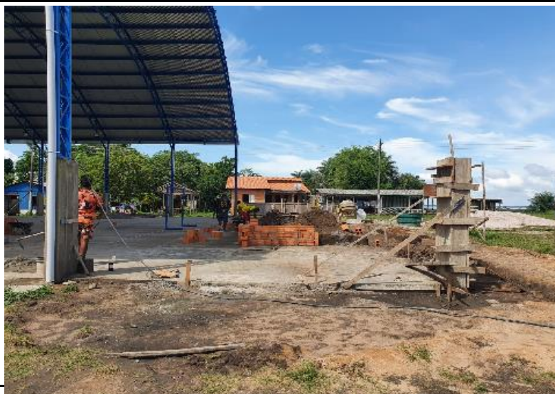
ATERRO E EXECUÇÃO DA ALVENARIA DO PALCO
