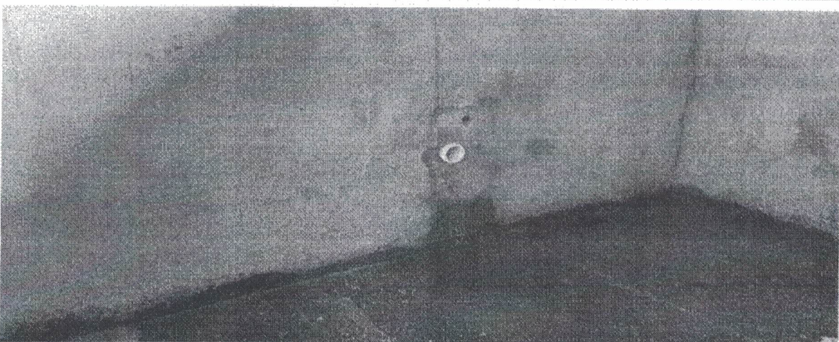
INSTALAÇÃO DA REDE HIDRO - SANITÁRIO
