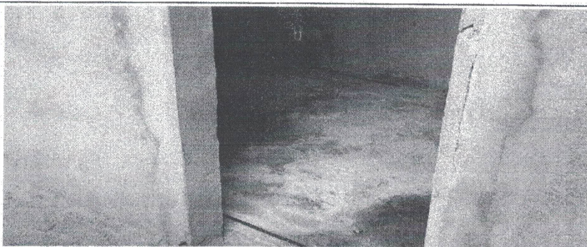
INSTALAÇÃO DO PISO KORODUR
