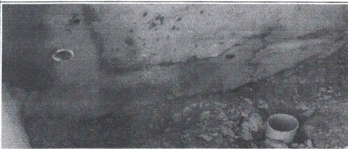
INSTALAÇÃO DA REDE HIDRO - SANITÁRIO
