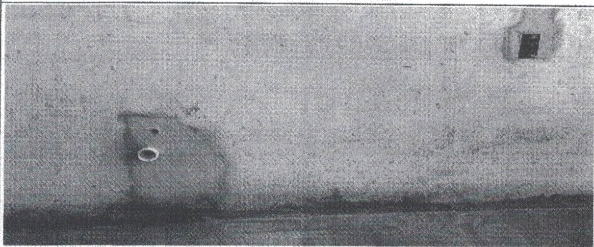
INSTALAÇÃO DA REDE HIDRO - SANITÁRIO
