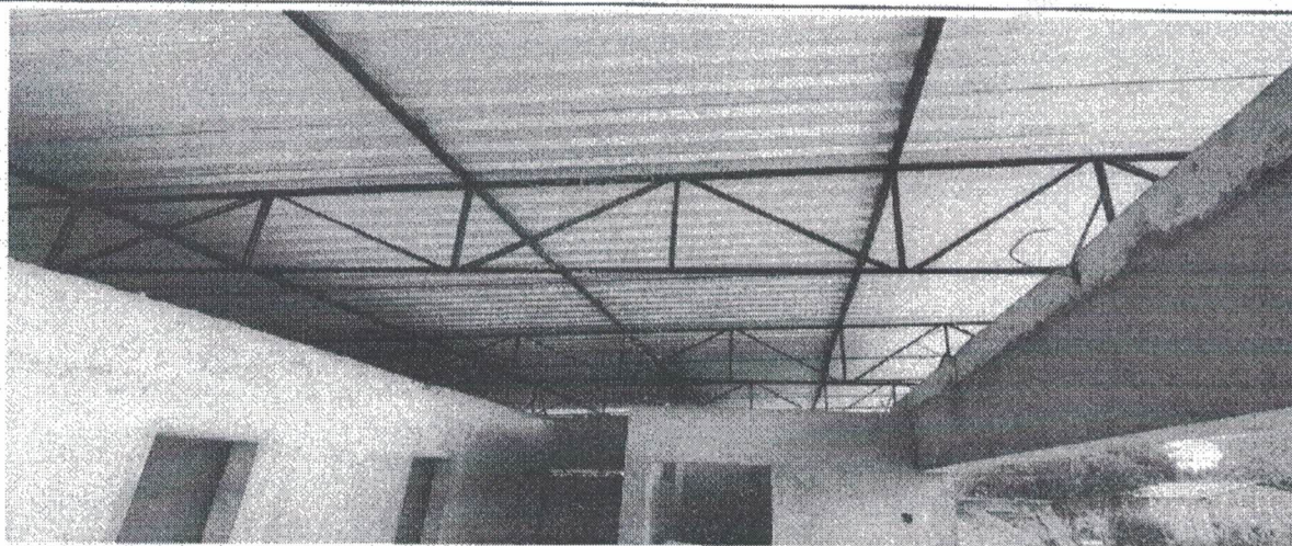
COBERTURA DA UBS
