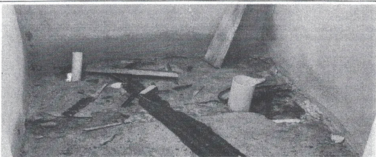
INSTALAÇÃO DA REDE HIDRO - SANITÁRIO
