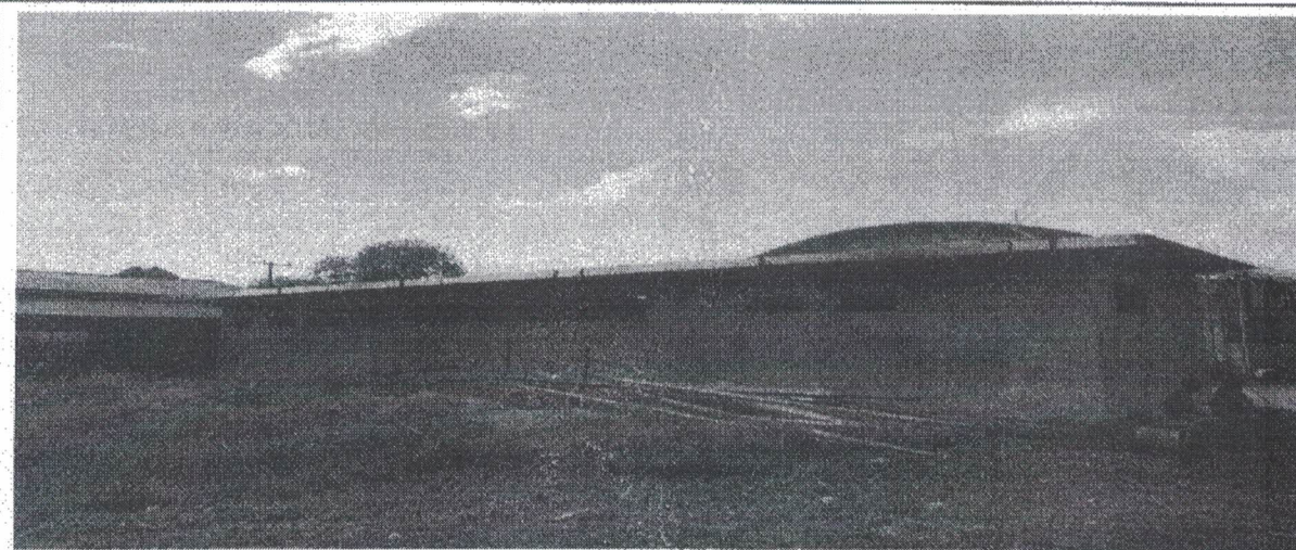
COBERTURA DA UBS
