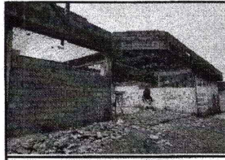
Limpeza e Demolições
