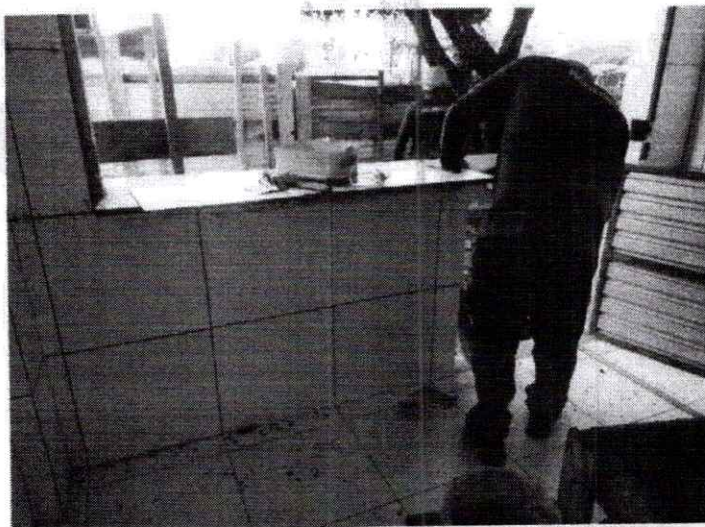
APLICAÇÃO DE FUNDO SELADOR ACRÍLICO EM PAREDES, UMA DEMÃO.
