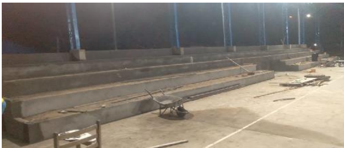
ARQUIBANCADA FINALIZADA, CHAPISCADA E REBOCADA E COM CONTRA PISO PRONTO
