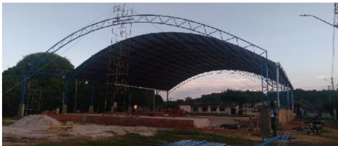
PILARES E TESOURA METÁLICA INSTALADA
