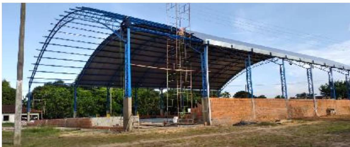
TESOURA E TERÇAS METÁLICAS INSTALADAS
