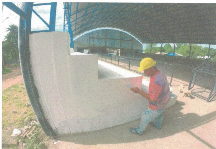
APLICAÇÃO DE SELADOR ACRÍLICO E MASSA ACRÍLICA NAS ARQUIBANCADAS
