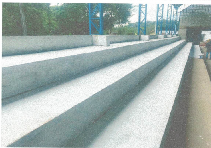
APLICAÇÃO DE SELADOR ACRILICO E MASSA ACRILICA NAS ARQUIBANCADAS
