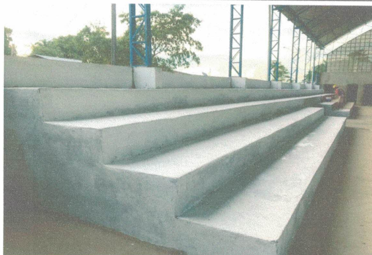
APLICAÇÃO DE SELADOR ACRÍLICO E MASSA ACRÍLICA NAS ARQUIBANCADAS
