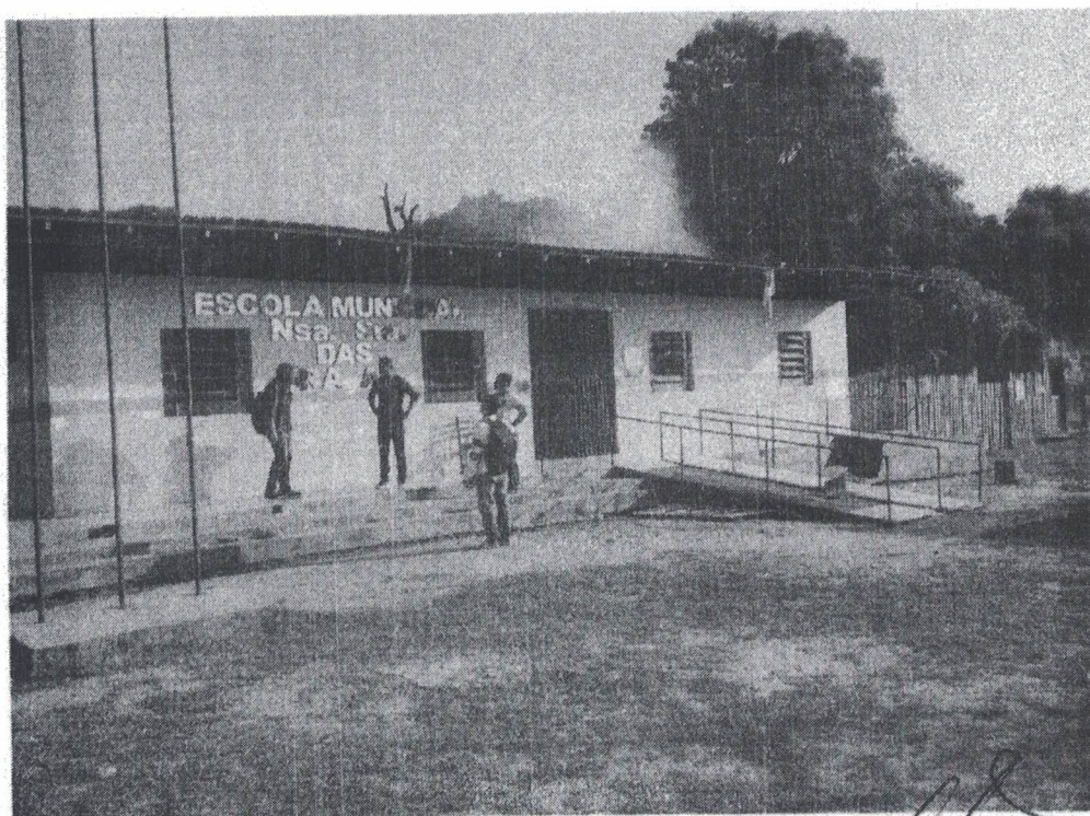
Fachada Frontal da Escola
