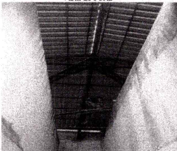
Estrutura Metálica e Cobertura com Telha Galvalume
