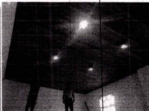
Instalação de Luminárias
