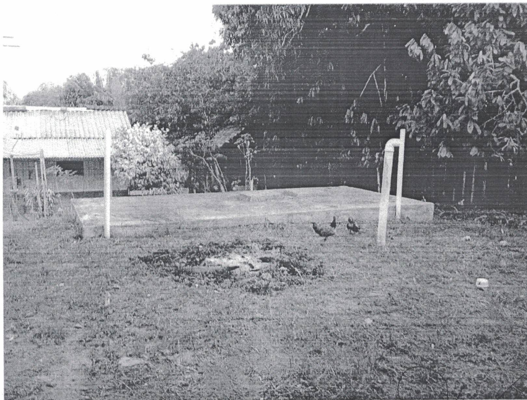
Fossa e Sumidouro existente
