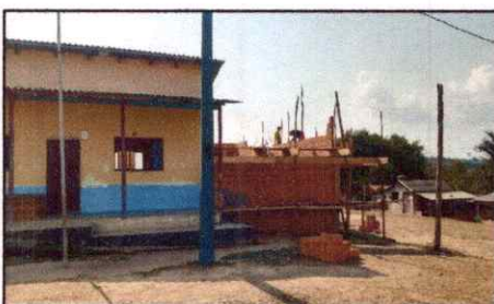
ALVENARIA EM ANDAMENTO
