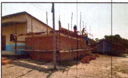
CAIXARIAS DOS PILARES E VIGAS EXECUTADOS
