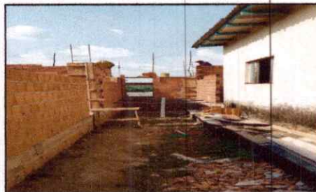
VIGAS BALDRAME FINALIZADAS
