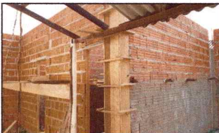
ALVENARIA E PILARES DA SUPRA EM ANDAMENTO
