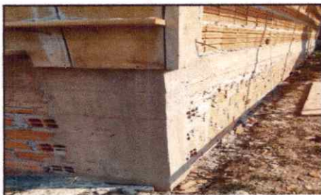
PILARES E BLOCOS DE FUNDAÇÃO EXECUTADOS
