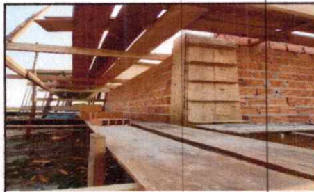
CAIXARIAS DOS PILARES E VIGAS EXECUTADOS
