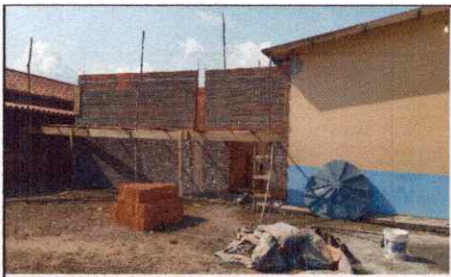
ALVENARIA E CHAPISCO SENDO EXECUTADOS
