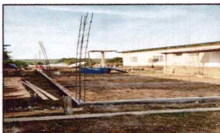
VIGAS E BLOCOS DE FUNDAÇÃO EXECUTADOS
