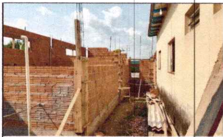
PILARES DA SUPRA EM ANDAMENTO
