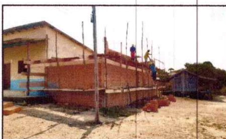
FORMAS E ALVENARIA SENDO EXECUTADA
