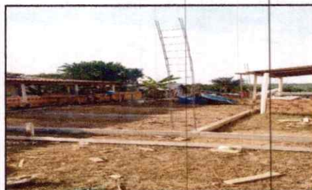
VIGAS E BLOCOS DE FUNDAÇÃO EXECUTADOS
