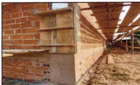
VIGAS BALDRAME FINALIZADAS
