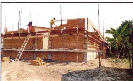
CAIXARIAS DOS PILARES E VIGAS EXECUTADOS
