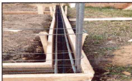
VIGAS DE CINTAMENTO EM EXECUÇÃO
