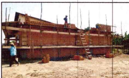
ALVENARIA SENDO DEVIDAMENTE EXECUTADA
