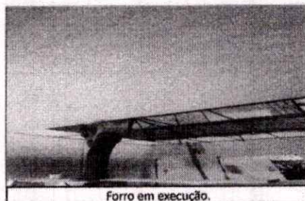
Forro em execução.
