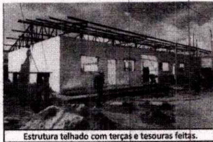
Estrutura telhado com terças e tesouras feitas.
