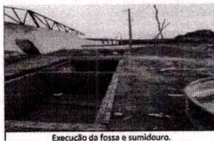
Execução da fossa e sumidouro.
