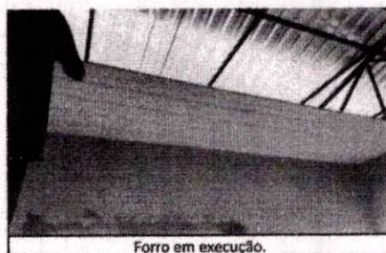
Forro em execução.
