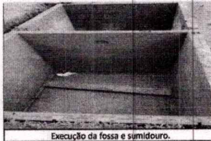
Execução da fossa e sumidouro.
