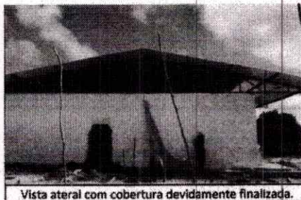
Vista lateral com cobertura devidamente finalizada.
