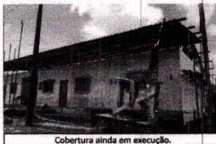
Cobertura ainda em execução.
