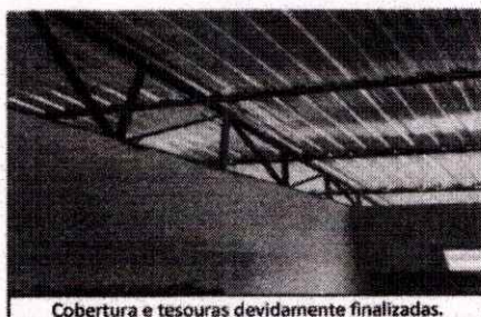
Cobertura e tesouras devidamente finalizadas.
