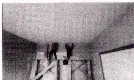
Forro sendo finalizado.
