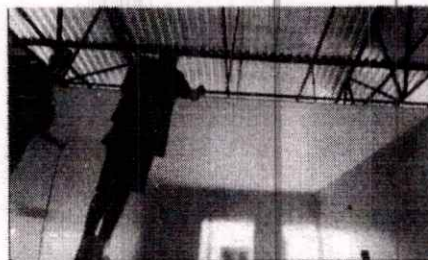
Forro em execução.
