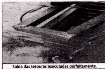
Solda das tesouras executadas perfeitamente.
