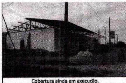
Cobertura ainda em execução.
