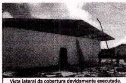
Vista lateral da cobertura devidamente executada.
