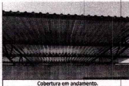
Cobertura em andamento.
