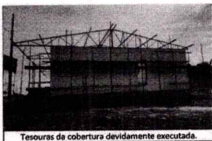
Tesouras da cobertura devidamente executada.
