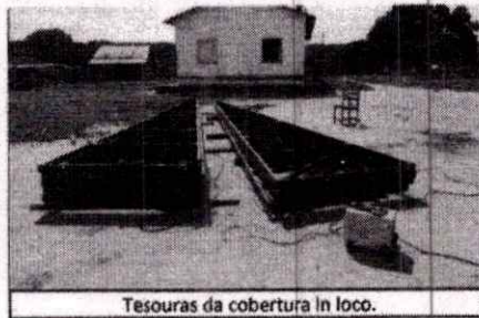
Tesouras da cobertura in loco.
