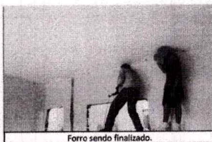
Forro sendo finalizado.
