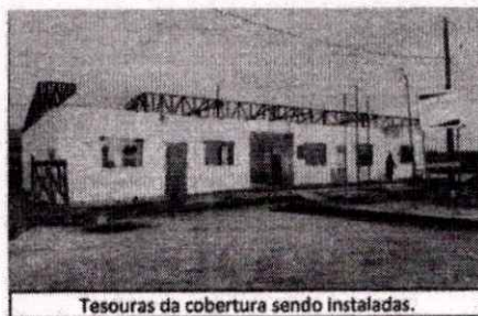
Tesouras da cobertura sendo instaladas.
