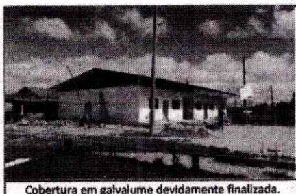
Cobertura em galvalume devidamente finalizada.
