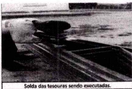
Solda das tesouras sendo executadas.
