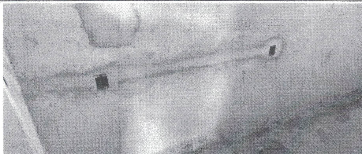
CHUMBAMENTO DAS CAIXINHAS 4X2 DA ELETRICA
