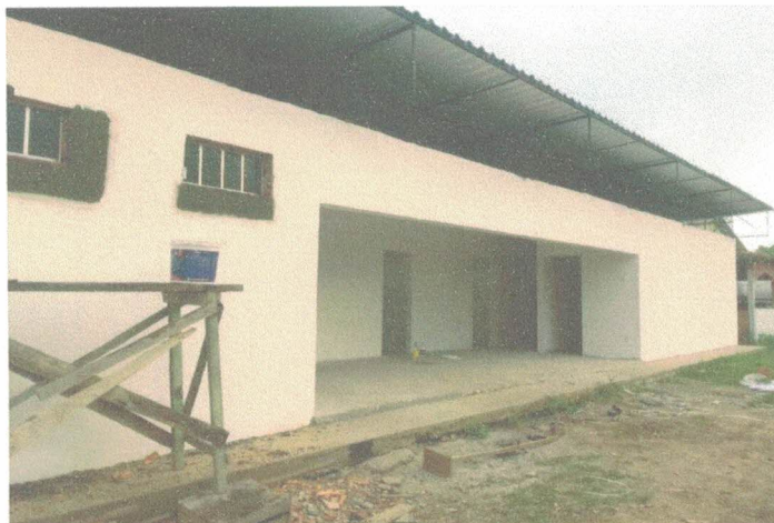
APLICAÇÃO DE MASSA ACRÍLICA
