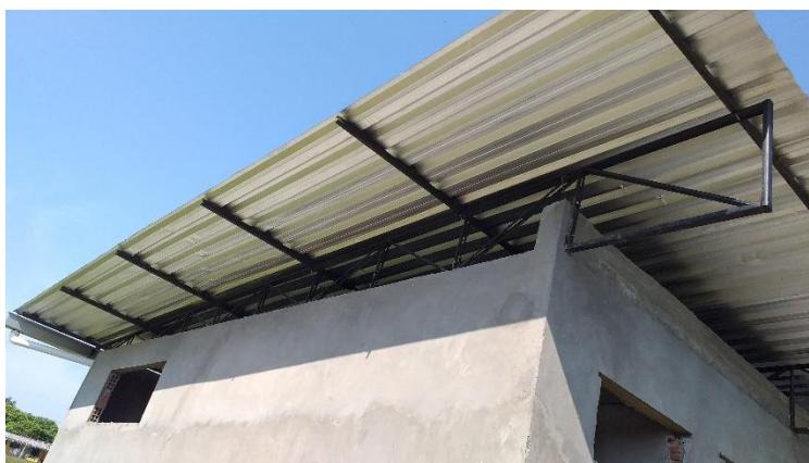
FOTO 07: UNIDADE BÁSICA S TOMÉ, SEU TELHADO, COM ALGUNS AMASSADOS, POREM SEM FUROS OU RASGOS:
