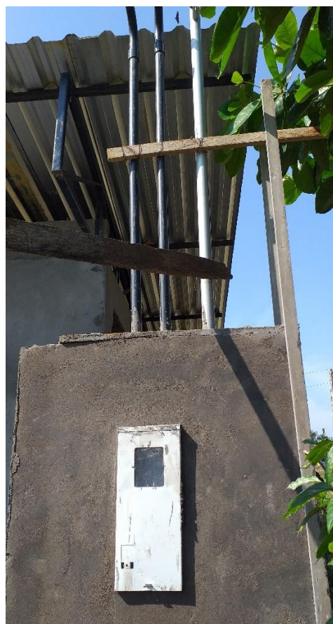
FOTO (3): OBRA DA UBS S TOMÉ, SUAS INSTALAÇÕES ELETRICAS EM FASE INICIAL, SUA MURETA. PONTO DE PARTIDA, E AMBIENTES E PONTOS;
