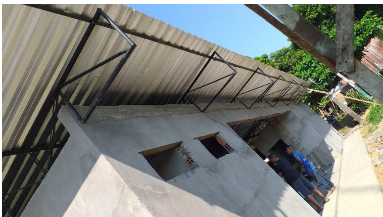
FOTO (3): UNIDADE BÁSICA S TOMÉ, TELHADO, CALHA, REDE CONTUDORA (TUBOS) DE AGUAS DO TELHADO;
