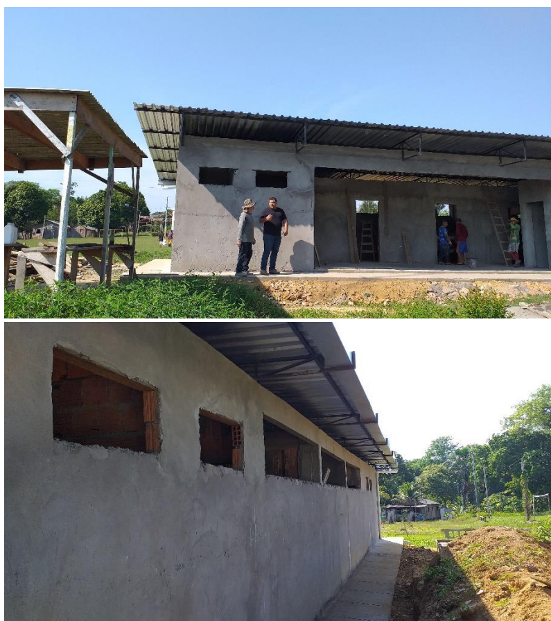
FOTOS (2): UNIDADE BASICA S TOMÉ, EDIFICAÇÃO DE ALVENARIA, FACHADA E FUNDO, DEVIDAMENTE EMBUÇADAS, CALÇADA E TELHADO COM CALHA;
