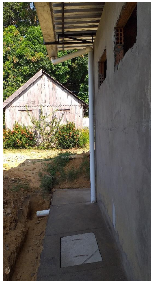
FOTO (3): UNIDADE BÁSICA S TOMÉ, TELHADO, CALHA, REDE CONTUDORA (TUBOS) DE AGUAS DO TELHADO;
