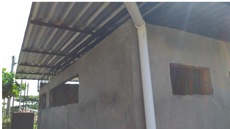
FOTO (3): EDIFICAÇÃO DA UBS S TOMÉ, A IMPLANTAÇÃO DOS PONTOS HIDRÁULICO NOS RESPECTIVOS AMBIENTES;
