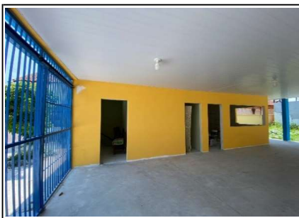
Pintura, forro e eletrica
