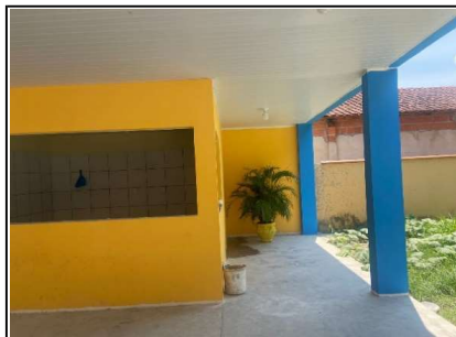
Pintura, forro e eletrica
