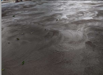
Execução piso corundum
