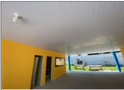
Pintura, forro e eletrica
