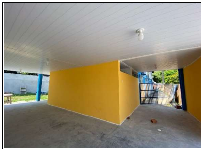
Pintura, forro e eletrica
