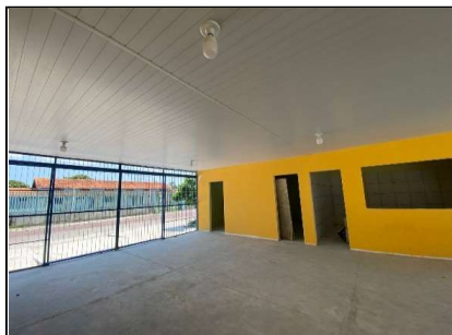
Pintura, forro e eletrica
