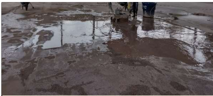
Execução piso corundum
