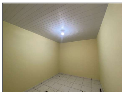
Pintura, Forro, Eletrica e ceramica
