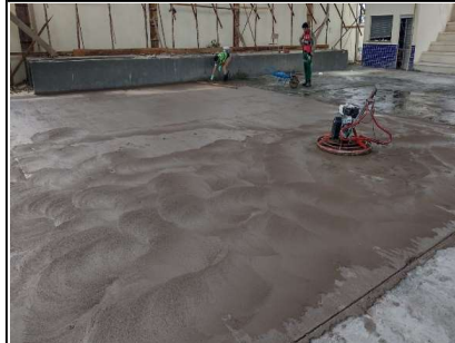
Execução piso corundum
