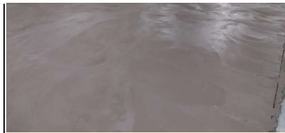
Execução piso corundum
