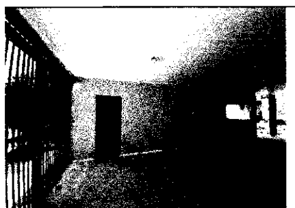
Pintura, forro e eletrica
