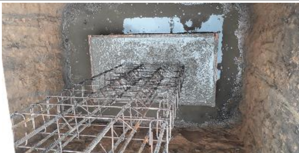
CONCRETAGEM DE BLOCO DE FUNDAÇÃO
