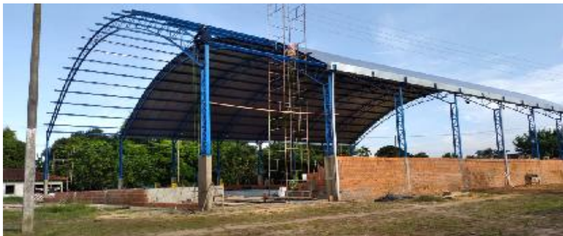
TESOURA E TERÇAS METÁLICAS INSTALADAS
