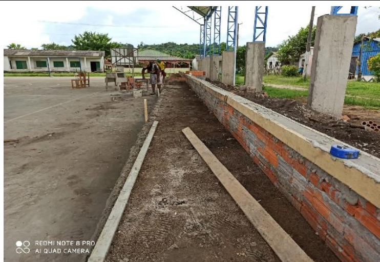
SERVIÇO DE ATERRO NA PARTE INTERIOR DOS PATAMARES DOS DEGRAIS DAS ARQUIBANCADAS
