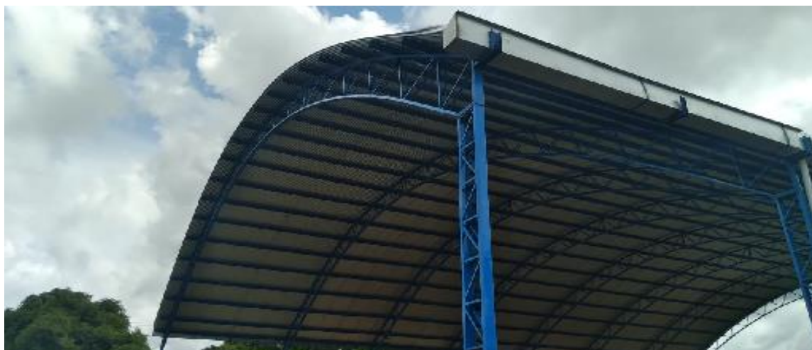
COBERTURA AMPLIADA, COM CALHAS INSTALADAS E PRONTAS PARA USO
