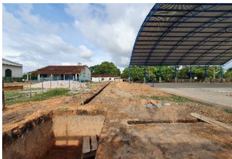
ESCAVAÇÃO DAS SAPATAS, VIGA BALDRAME E BLOCOS DA FUNDAÇÃO
