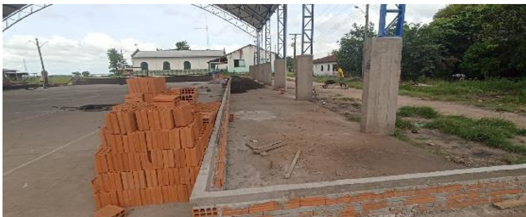
ALVENARIA COM TIJOLO DEITADO NO PRIMEIRO PATAMAR DA ARQUIBANCADA
