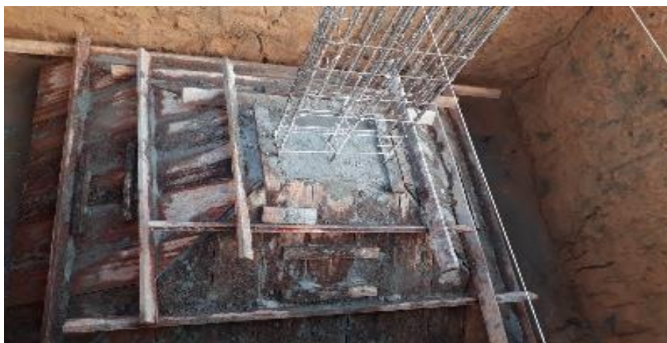
FORMA, FERRAGEM E CONCRETO DAS SAPATAS DE EXTREMA
