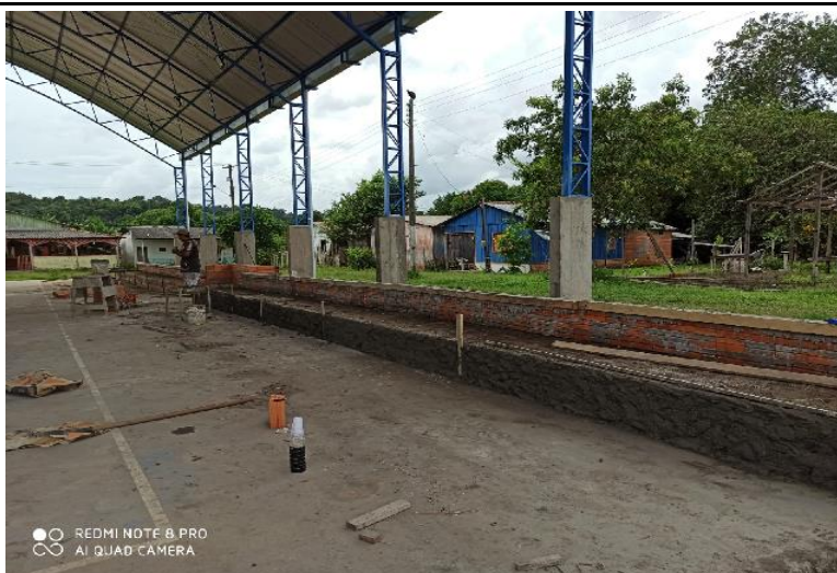
SERVIÇO DE ATERRO NA PARTE INTERIOR DOS PATAMARES DOS DEGRAIS DAS ARQUIBANCADAS
