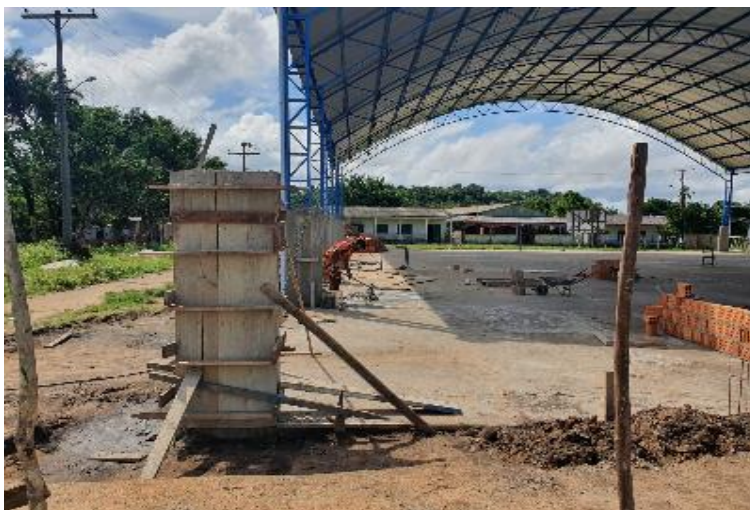
FABRICAÇÃO DE PAINEIS EM MADEIRA DE LEI PARA FORMA DOS PILARES
