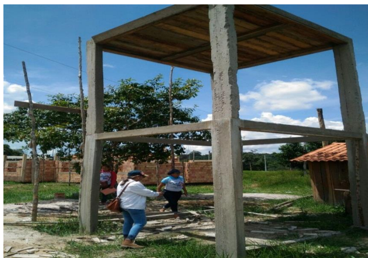
Figura 23 – Monitoramento na obra PDDE/Estrutura/Água na Escola – Escola Municipal Maria Júlia
