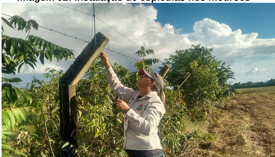
Imagem 02: Instalação de espículas nos mourões
