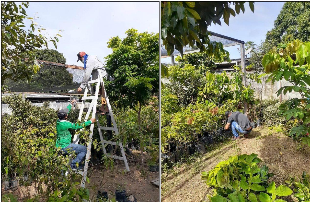
Imagem 78 - Trabalhos internos para reparos no Viveiro Municipal
