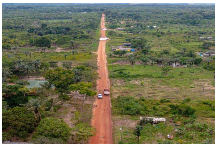
Imagem 81 - Pavimentação da estrada Vila Amazônia Valéria
