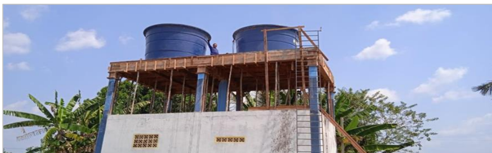
Imagem 167 - Melhorias no Sistema de Abastecimento de Água
