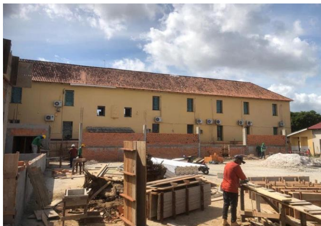
Imagem 77 - Construção de Ginásio Colégio Nossa Senhora do Carmo
